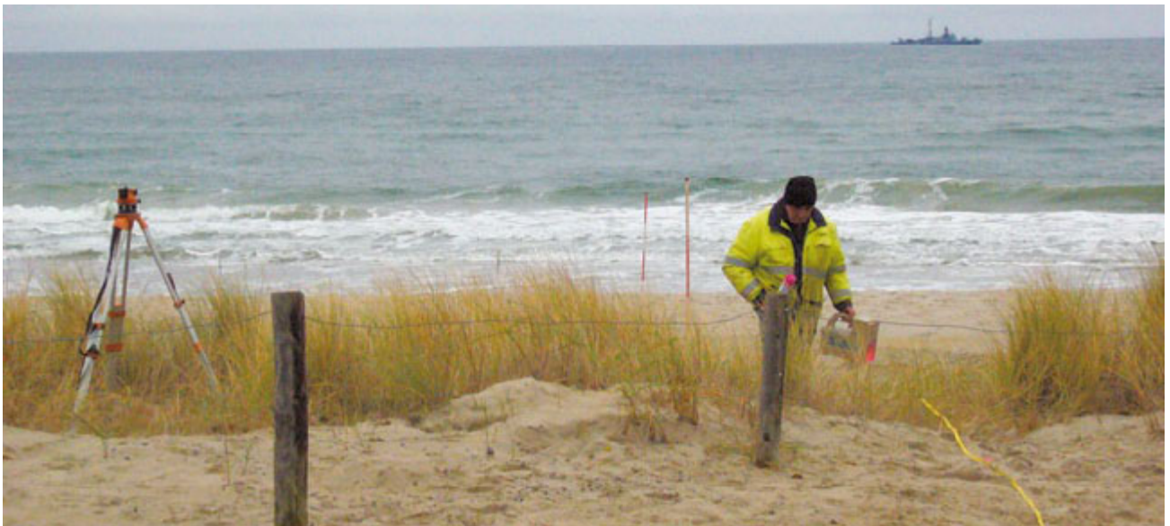
Durchörterung von Düne und Strand, um beim Bau der Messstrecke den Eingriff in die Natur so gering wie möglich zu halten
