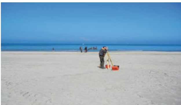
1.29 > Einbauarbeiten zur Messstrecke am Standort Warnemünde (Quelle: GICON GmbH)
