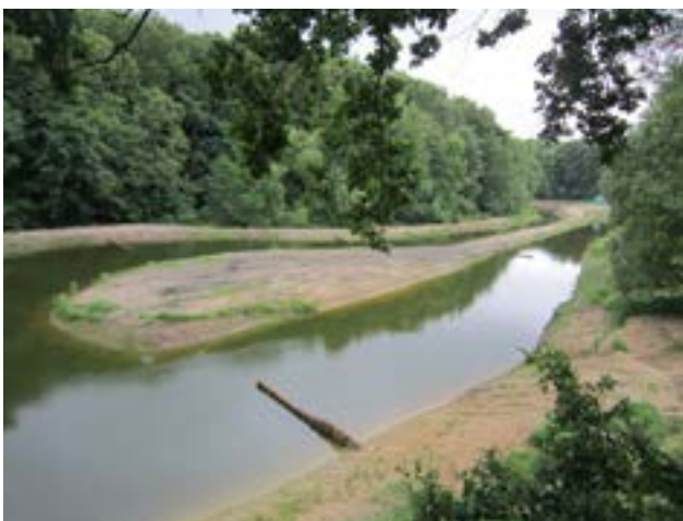
1.46 > Blick auf das Retentionsbecken Jürgenshagen. Im Vordergrund ist eine von mehreren Pfahlreihen zu erkennen, die zur Verlängerung der Aufenthaltsdauer des Dränwassers dienen.
