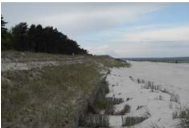
1.19 > Faschinen zur Dünensicherung
