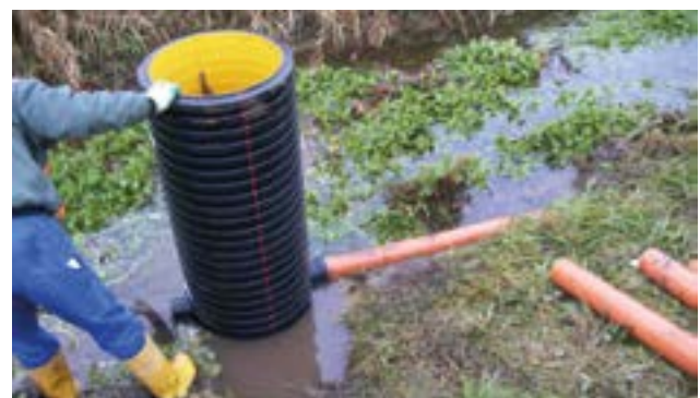
1.49 > Regelungseinheit Typ „Rostock“ vor dem Einbau
