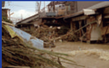
図2：土砂災害による民家への被害（山口地区）
