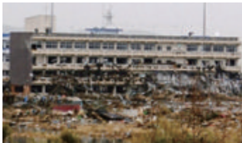
図 1： 津波で破壊された校舎 気仙沼向洋高校
